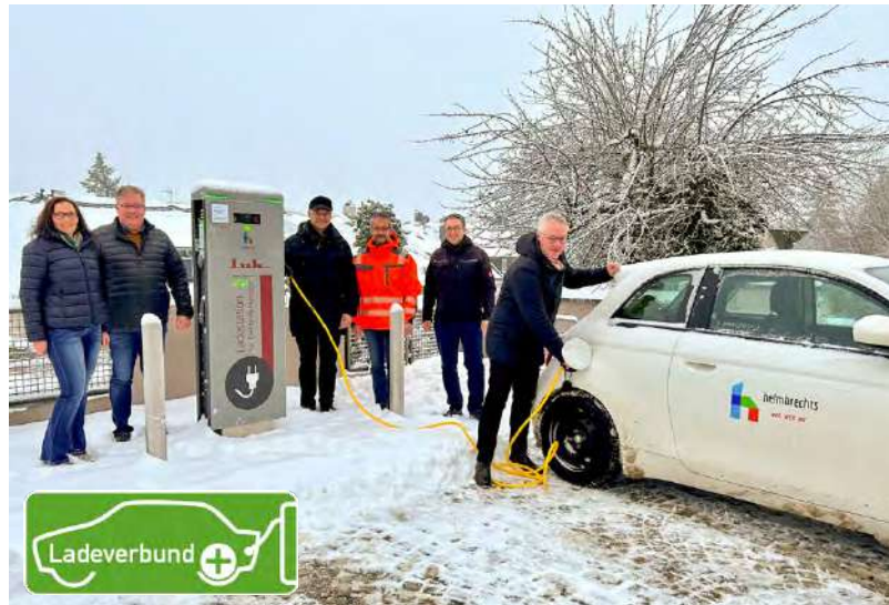
Weiheten gemeinsam die neue Ladesäule am Helmbrechtser Rathaus ein (v. re.): Bürgermeister Stefan Pöhlmann, Prokurist Stefan Bußler, Abteilungsleiter Strom Marco Zuber, Geschäftsführer Gerd Dilsch (alle LuK) mit Bauamtsleiter Manuel Thieroff und Alexandra Hüttner vom städtischen Bauamt. Foto: Stadt Helmbrechts.
