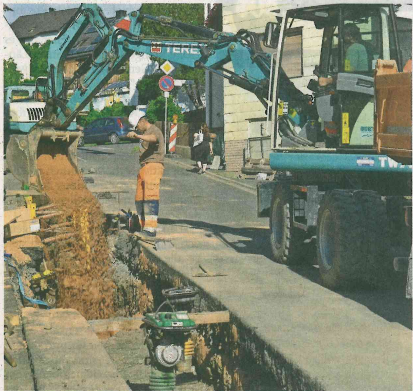
Ein Graben, zwei Leitungen: Im Zuge der Wasserleitung-Erneuerung werden in dem Nailaer Ortsteil die ersten Haushalte an das öffentliche Erdgas-Netz angeschlossen.
