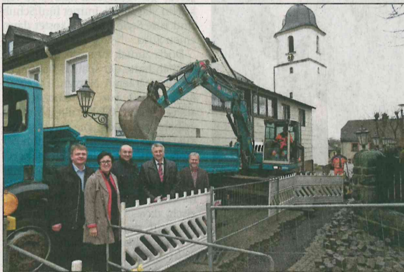
Sie machten sich auch ein Bild von den Bauarbeiten im Stadtkern (von links): Kundenberater Udo Meister, Bürgermeisterin Elke Beyer, GFW-Geschäftsführer Gerd Dilsch sowie Günter Wolf und Reinhard Luding von der gleichnamigen Firma aus Regnitzlosau.
